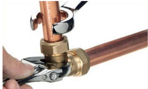
Met de juiste kracht en gereedschap vastdraaien
