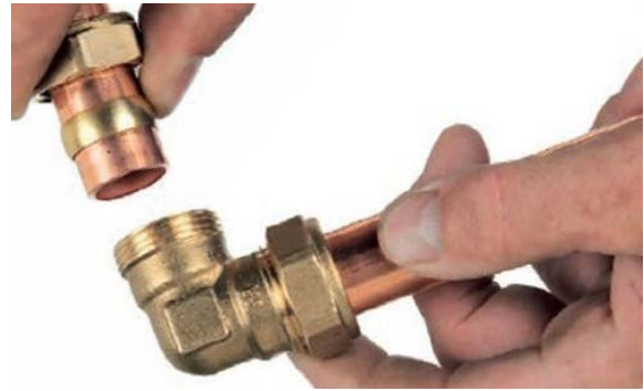
Plaatsen van wartel + knelring op cv-buis
